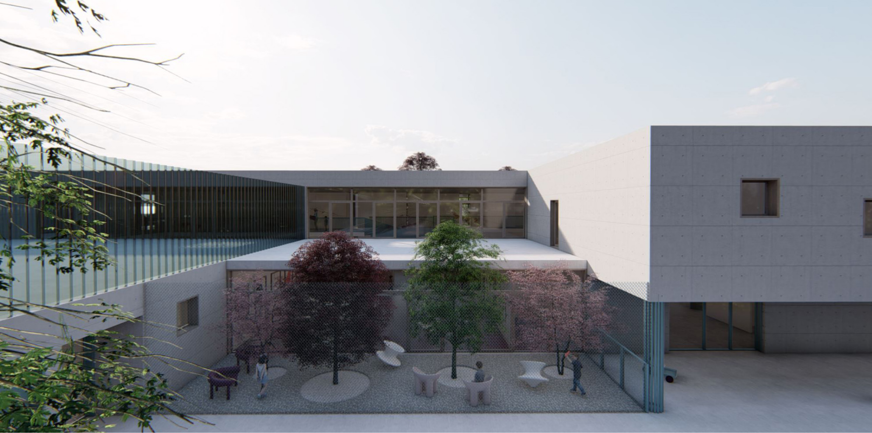
Pogled: sjeverozapadno pročelje, zgrada gospodarstva, uprave i PVN
