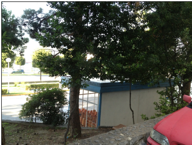
spremište plinskih boca
