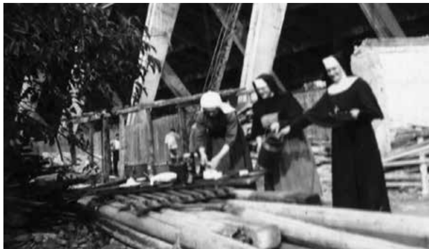
IZGRADNJA ZAPADNE TRIBINE
