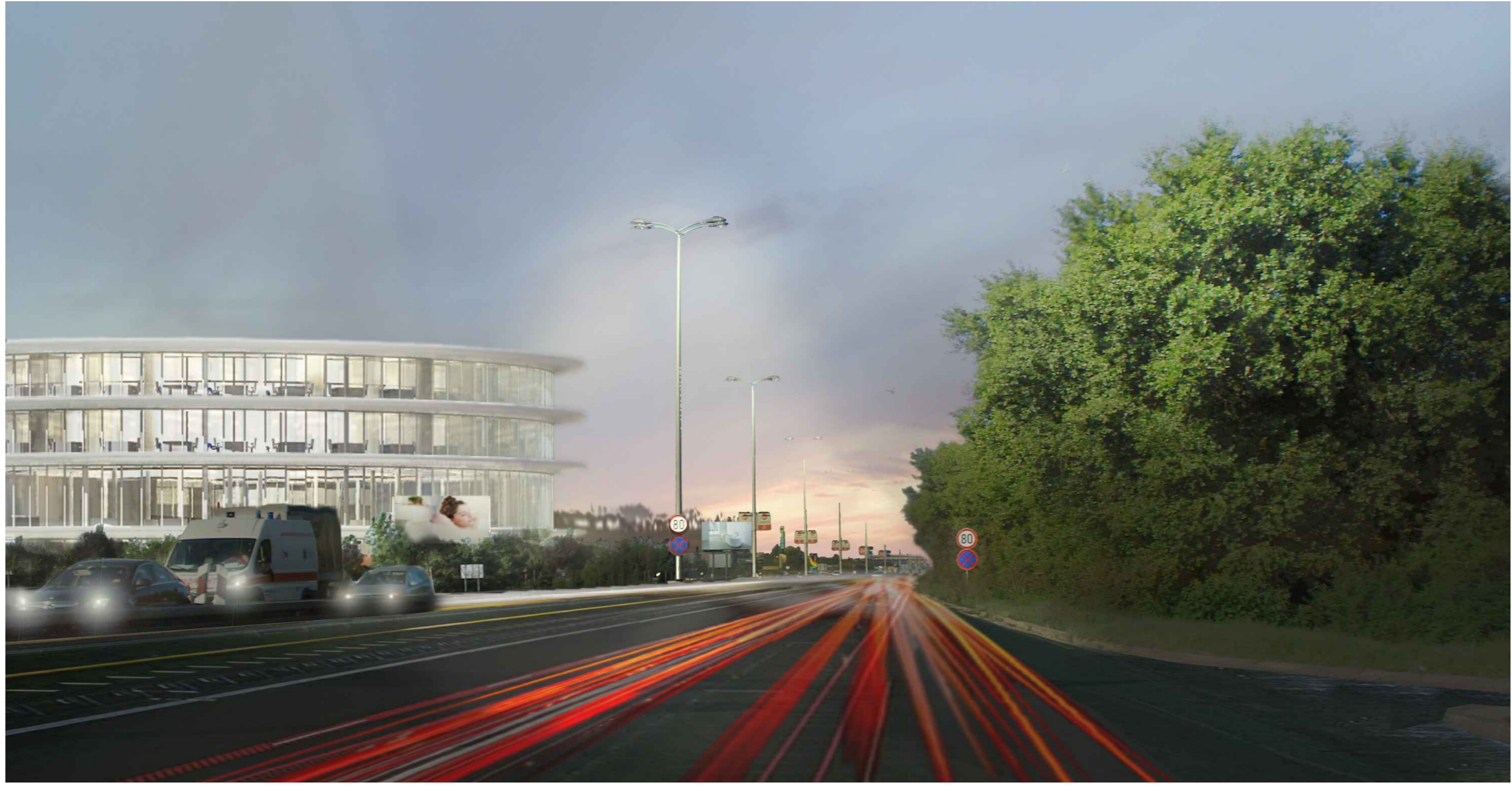
JADRANSKA AVENIJA - NOĆNI POGLED PREMA ZAPADU
